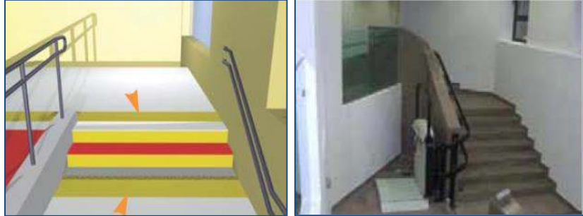
Figura 21 e Figura 22- Esempi di piattaforma elevatrice
