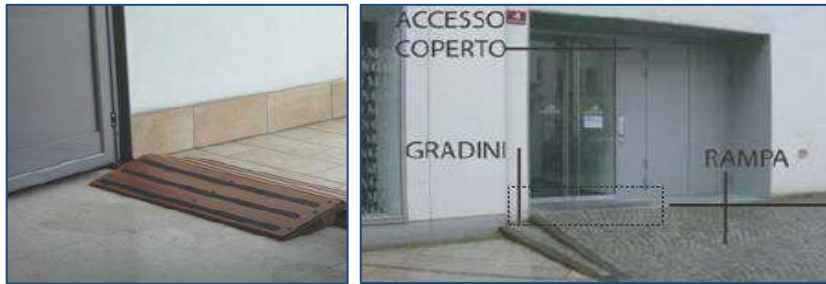
Figura 23e Figura 24 - Esempi di rampa di collegamento
