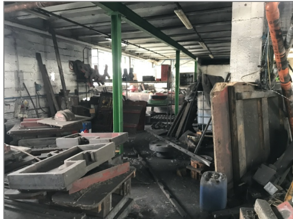
Rifiuti locali adiacenti al capannone lato ovest
