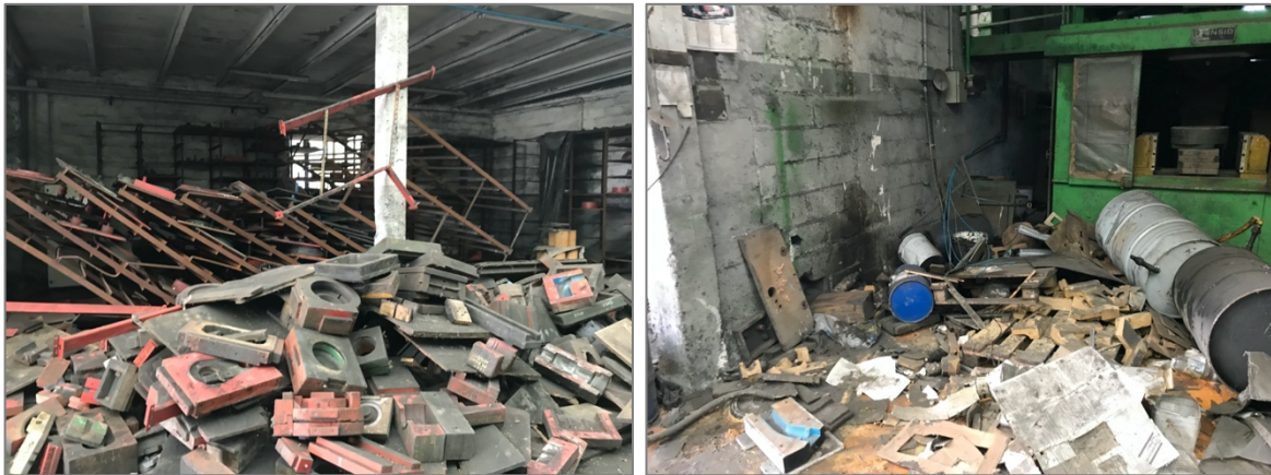
Locale adiacente al capannone principale (lato nord)
