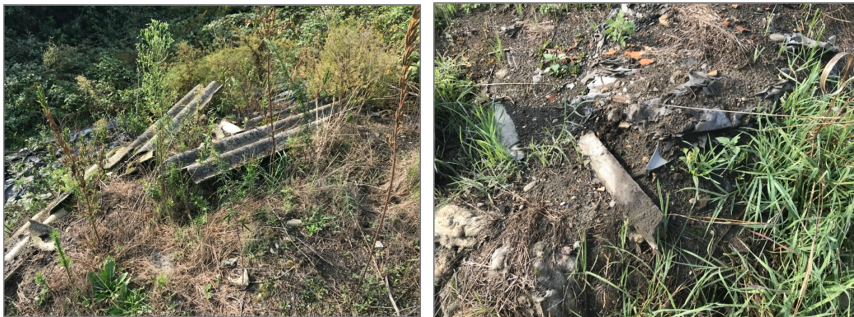
Particolari cumulo A con frammenti di lastre di cemento amianto
