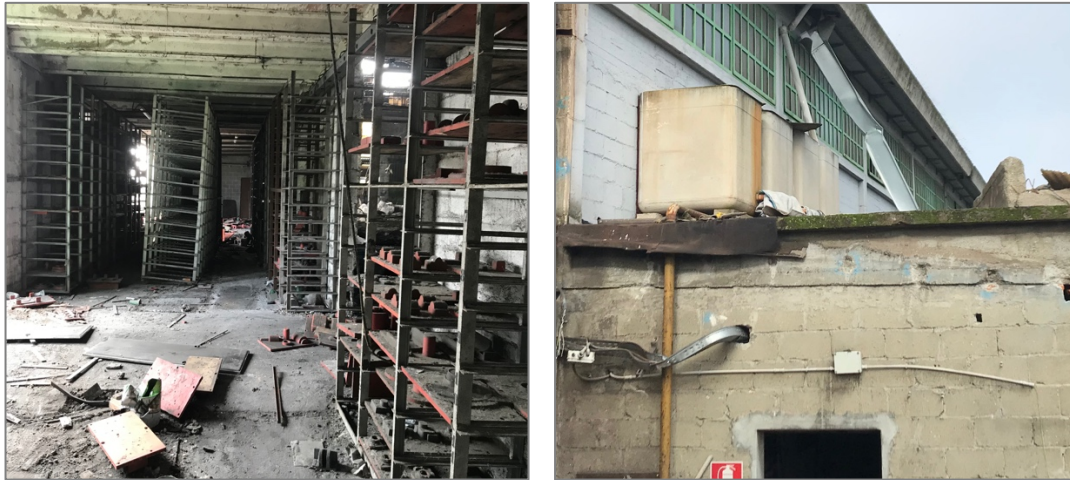
Particolare locale adiacente al capannone principale lato est e serbatoi in cemento amianto
