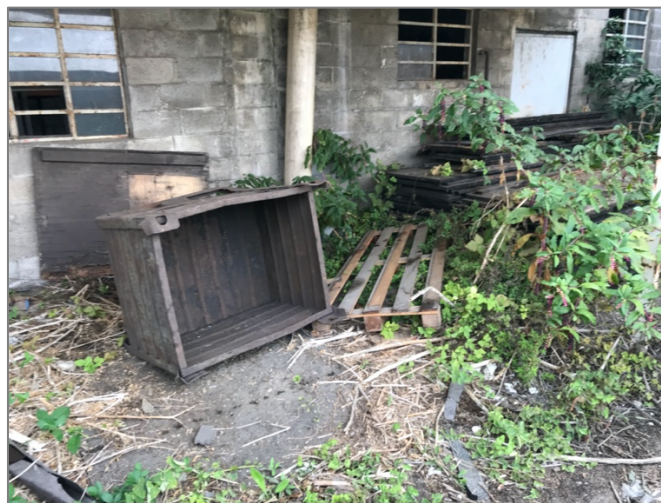
Particolare rifiuti sotto tettoia esterna dietro palazzina uffici
