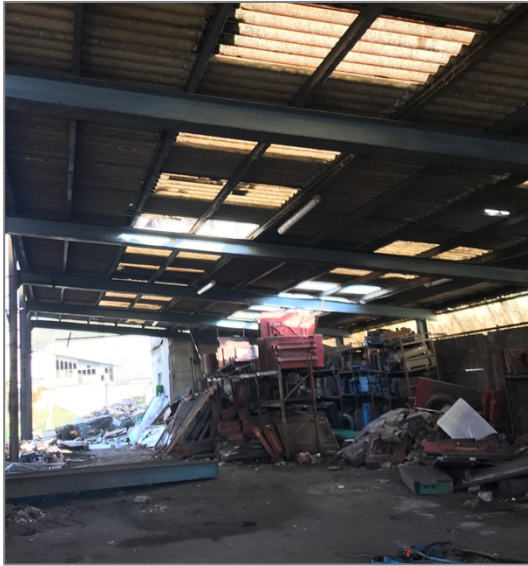
Tettoia a sud del capannone principale
