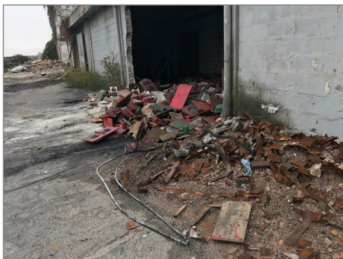
Particolare rifiuti lato capannone principale in affaccio su piazzale uffici
